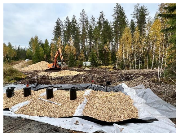
j. Väliseinät ohjaavat virtaamat tasaisesti koko rakenteeseen
