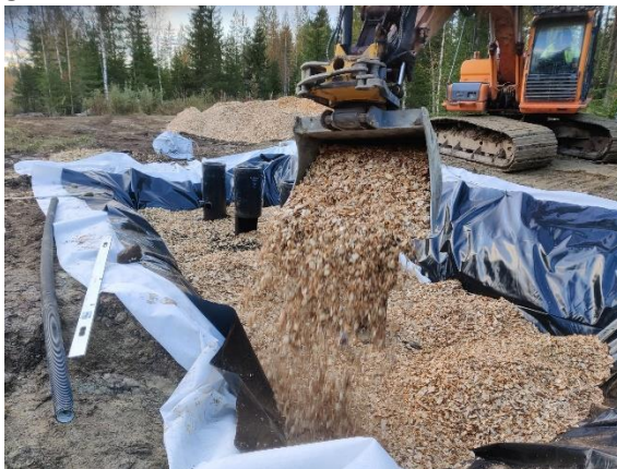
i. Haketta suodattimeksi
