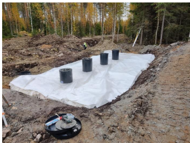
r. Huputettu ts. vain Suursuon laskuojasta ohjautuvat vedet pääsevät reaktoriin
