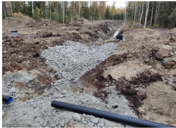
t. Ylivirtaamaojan eroosiosuojaus murskeella
