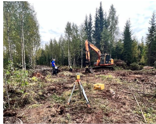
d. Reaktori työmaan vaaitus tasolaserilla
