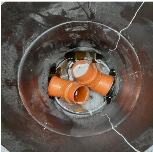
u. Loggerit kaivossa mittaamassa sähkönjohtavuutta
