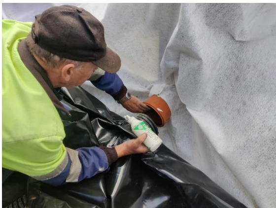
x. Tuloputkien tiivistämistä
