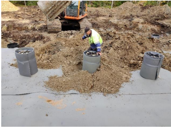
s. Routamatto bioreaktorin eristeeksi
