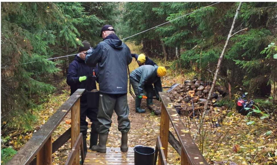
Kuva. Karelia AMK:n ympäristötekniikan opiskelijoita tutustumassa virtavesillä tehtäviin kunnostuksiin
