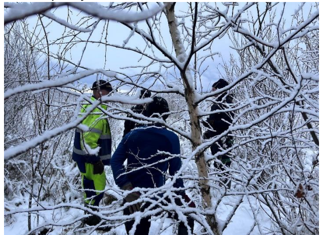
vaativa kohde raivata ja kaivaa, ajoitus pohdinnassa
