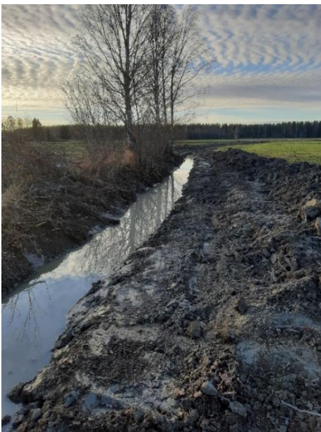
Juuri kaivettua kaksitasouomaa (kuva Osmo Oinonen)
